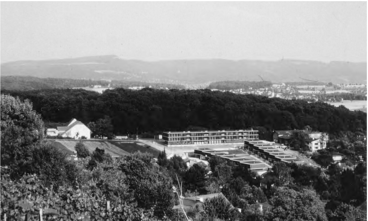
In sanfter Lage am Hang: Peter Zumthor's „Siedlung Spittelhof“ in Biel-Benken (1998).
